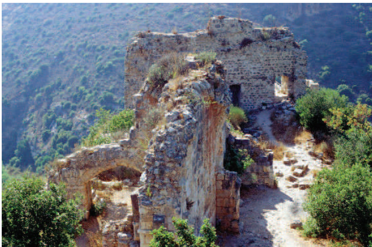
Abb. 10: Ehemaliger Saalbau, Blick nach Westen, im Vordergrund rechts die Räume F und G, links Raum D, im Hintergrund die Westwand des Saalbaus
