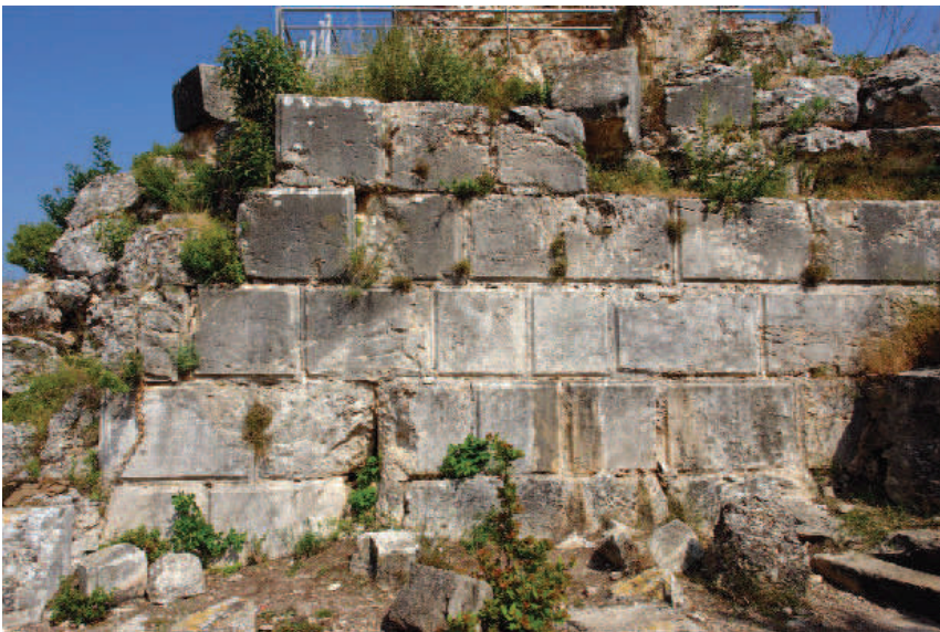
Abb. 5: Unterbau des Frontturms, Westfassade mit großformatigem Bossenquadermauerwerk
