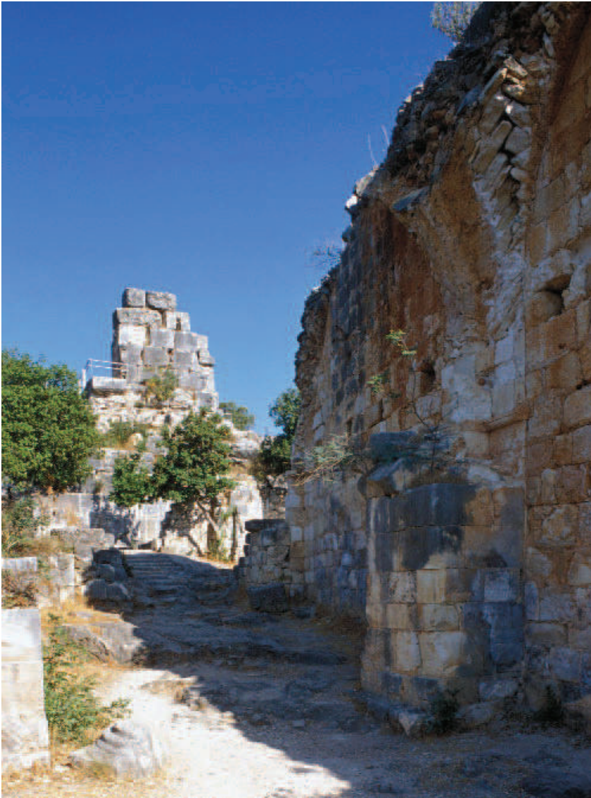
Abb. 11: Ehemaliger Saalbau, Blick in Raum G (rechter Bildrand) und F (Bildmitte), rechts Pfeiler, des einst offenen Saales mit sekundär aufgemauerten Zwischenwänden, im Hintergrund die innere Westwand des Frontturms
