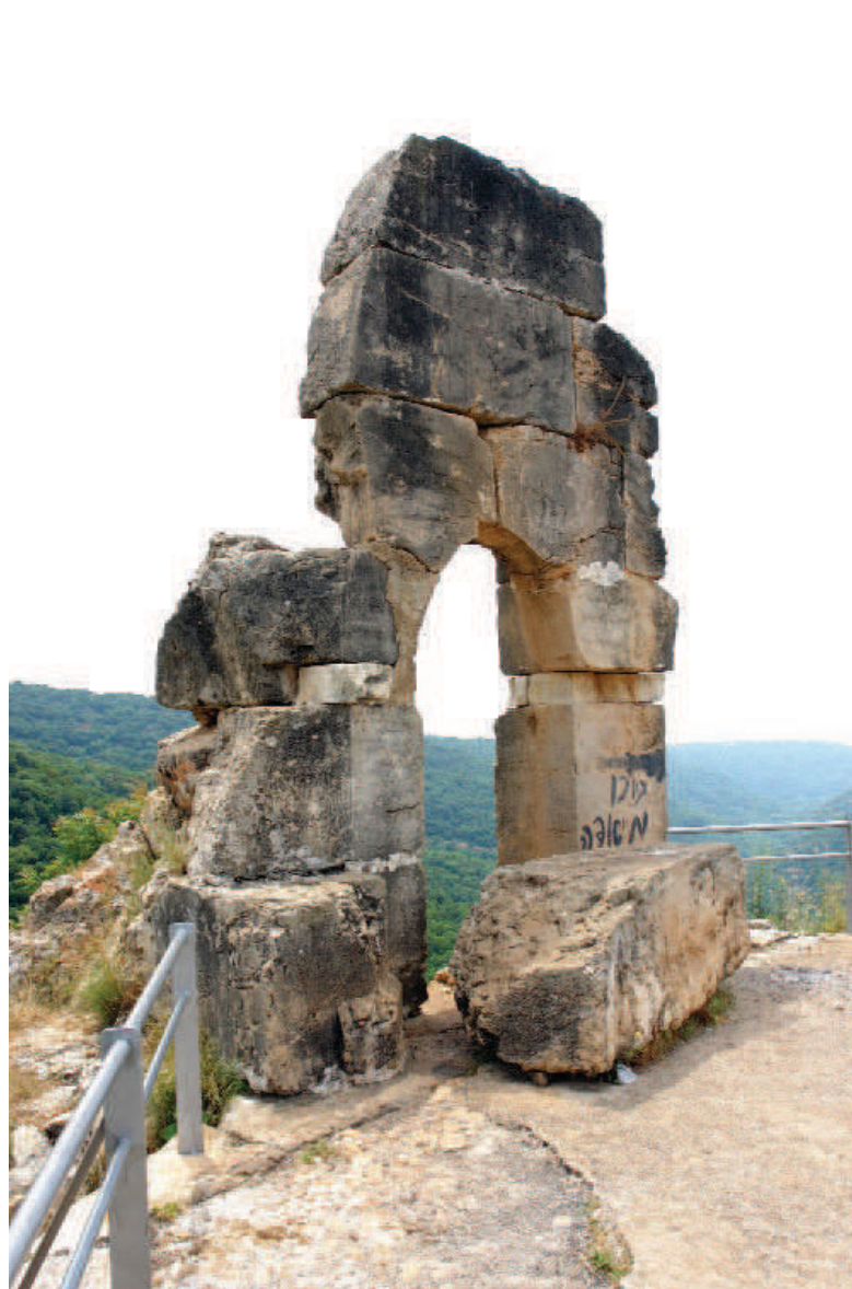
Abb. 7: Eingangsgeschoss des Frontturms, erhaltenes Portal in der südlichen Innenmauer mit Rest eines Wandpfeilers
