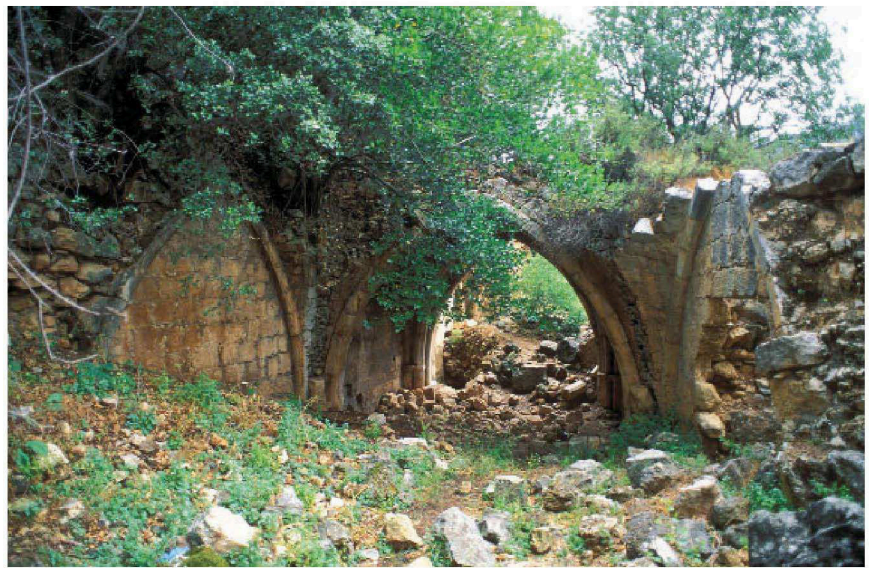
Abb. 19: Mühlengebäude, Reste des gewölbten Saals im Obergeschoss (zweite Bauphase), Blick nach Westen
