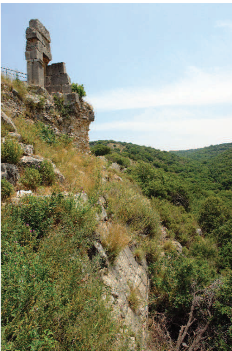
Abb. 6: Blick von Westen auf die Südflanke des Frontturms: unten im Bild der Turmsockel mit Schräge, oben links Rest der südseitigen Innenmauer des Eingangsgeschosses
