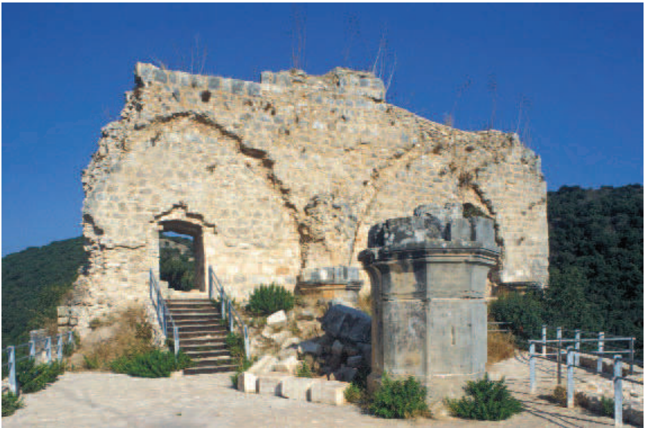
Abb. 14: Obergeschoss des Wohnturms (von Nordwesten), im Vordergrund der zentrale Gewölbepfeiler, im Hintergrund die Westwand des Saalbaus
